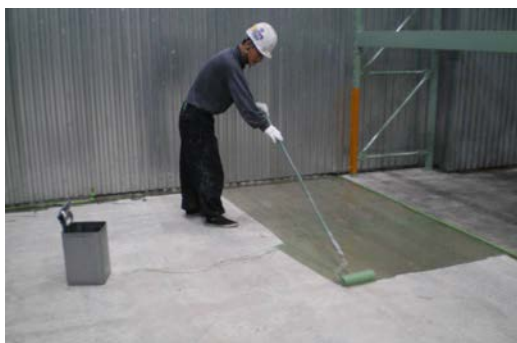
② プライマー塗布
